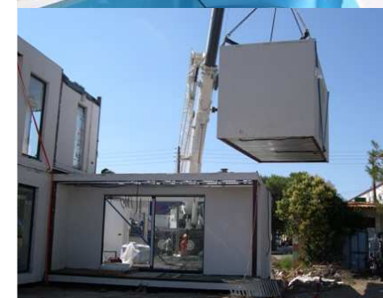
Figure 3 et 4: Assemblage sur site
