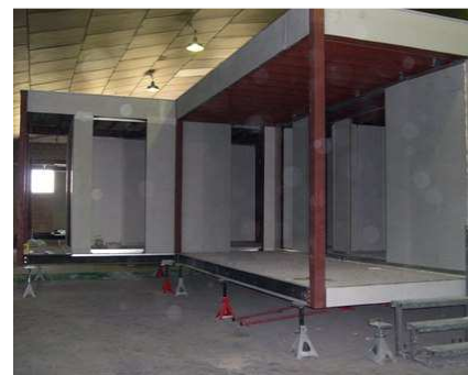
Figure 1: Préparation en usine
