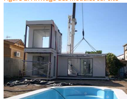
Figure 2: Arrivage des modules sur site
